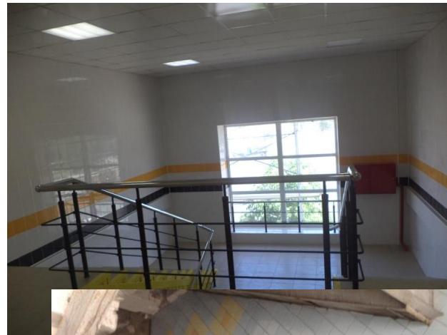
Помещения АБК после реконструкции
