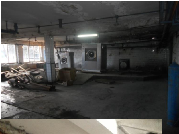
Помещения АБК до реконструкции
